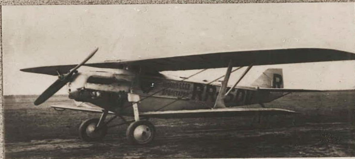
Цельнометаллический самолёт АНТ-3 конструкции А.Н.ТУПОЛЕВА. На таком самолёте совершены исторические перелёты: в 1926 г. — по Европе и в 1927 г. — по маршруту Москва —Токио.
